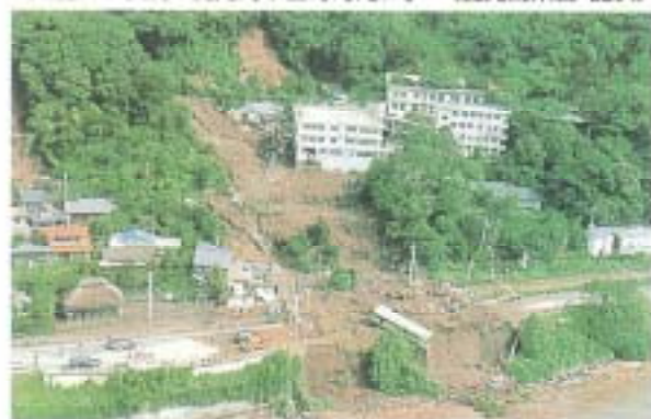
▼山崩れの状況 鹿児島市吉野町滝ヶ水 (鹿児島県警 提供)
